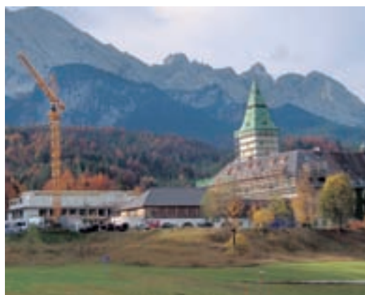
Hotel beim Wiederaufbau: Seit eineinhalb Jahren wird gebaut – im Juli dieses Jahres geht „The Schloss Elmau Experience“ wieder an den Start
