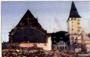
Ein Bild der Verwüstung: Nach dem verheerenden Feuer mussten der komplette Süd- und Ostflügel der Lustortherberge abgerissen werden.
